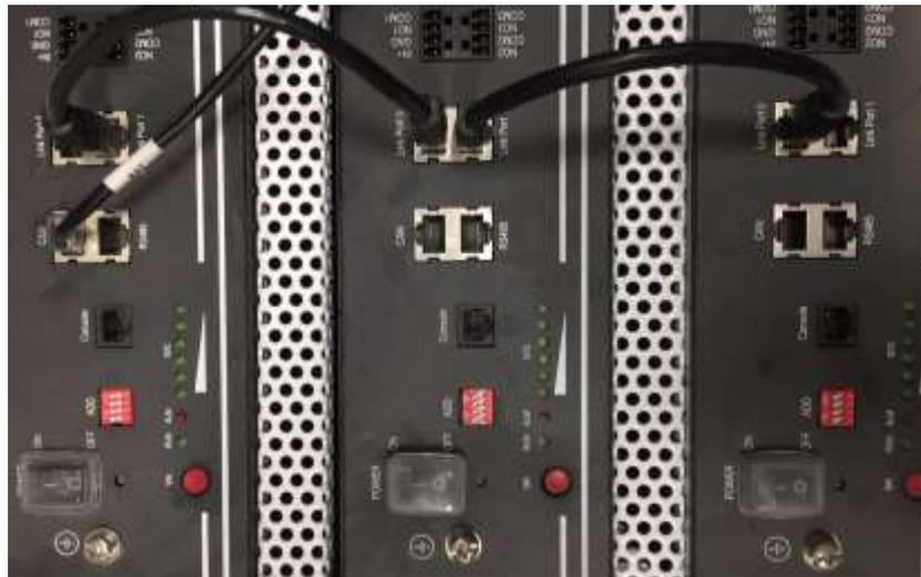
Figura 14 - Connessione di comunicazione tra tre batterie Pylontech
